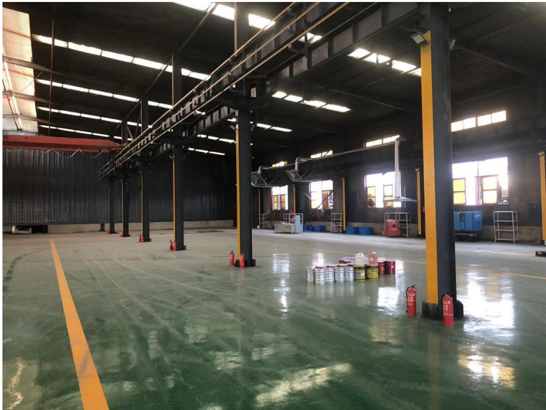
生产车间防渗区
