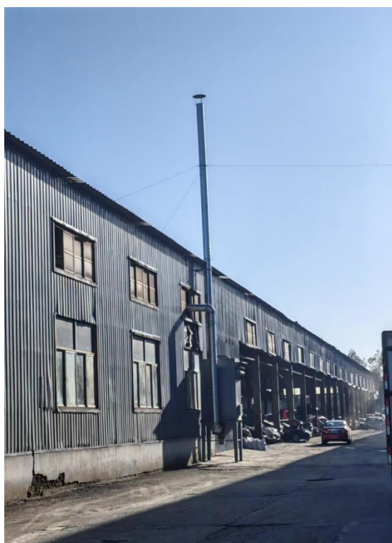
布袋除尘器+1 根 15m 高排气筒
