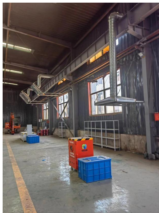
集气罩收集废油收集产生的非甲烷总烃
