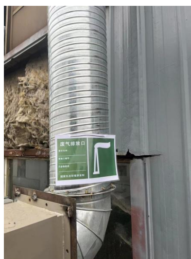
集气罩收集废油收集产生的非甲烷总烃
