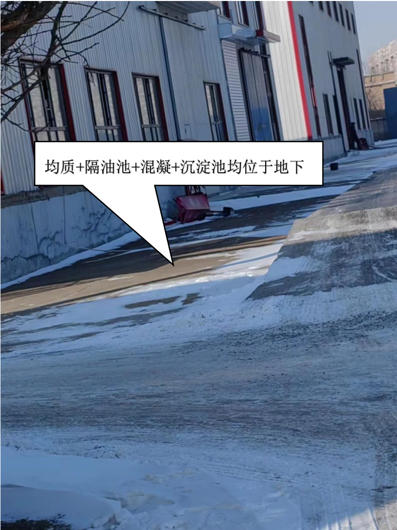
均质+隔油池+混凝+沉淀池均位于地下
