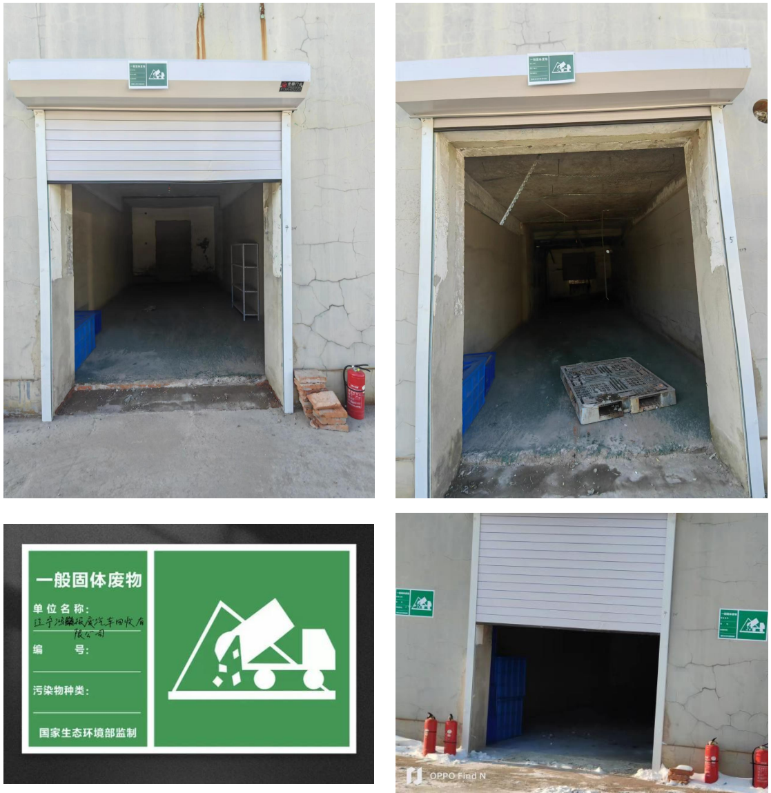
一般工业固体废物暂存区
